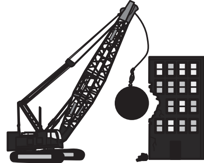
Bola de demolición derribando un edificio
